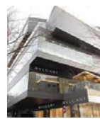
GYRE(ジャイル)ビル
